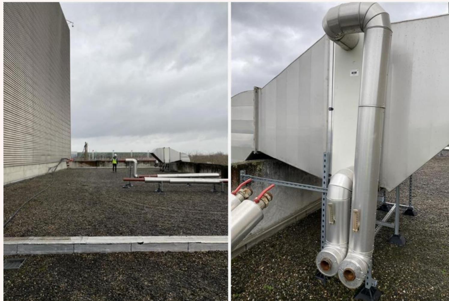
Intégration d'une batterie d'échange sur le rejet de l'installation d'aspiration centralisée
