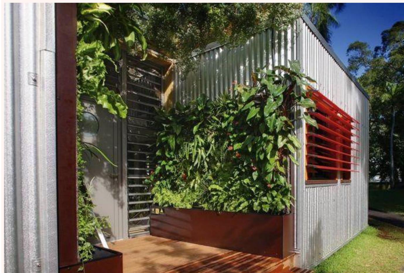
Ondulit est une tôle d'acier recouverte d'une couche de bitume et d'un film réfléchissant qui atteint un facteur solaire de 0,019.
